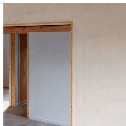
pintura de arcilla al rodillo, sobre arcilla base
